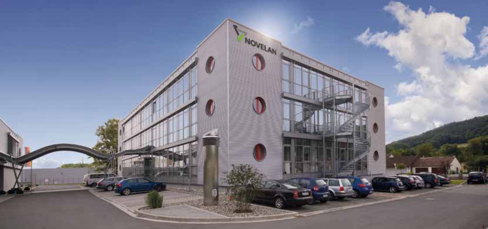
Zentrale NOVELAN in Kasendorf, Deutschland
